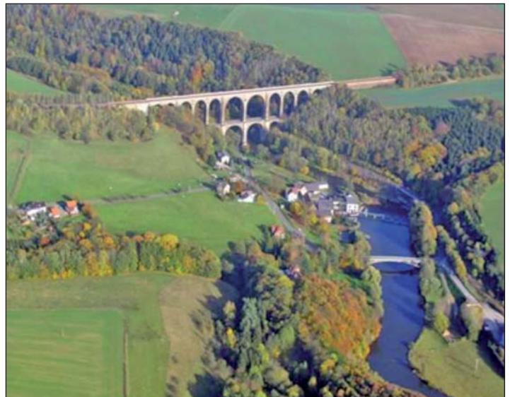
Die **Göhrener Brücke**, eine zweistöckige Steinbrücke, zählt zu den eindrucksvollsten Brückenbauten aus der Frühzeit des deutschen Eisenbahnwesens. Sie wurde 1869 bis 1871 gebaut, ist 68 m hoch und 312 m lang. Der Radler sollte sich in Wechselburg genügend Zeit für die vielen Sehenswürdigkeiten lassen!
